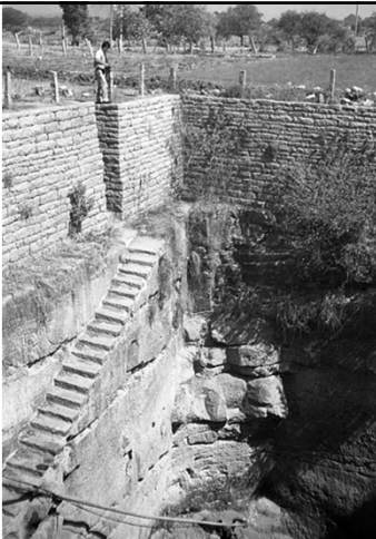
インドの 伝統的な井戸 (Open Well)
