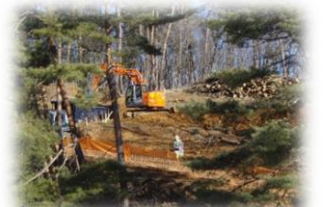
造成中の仮置場
