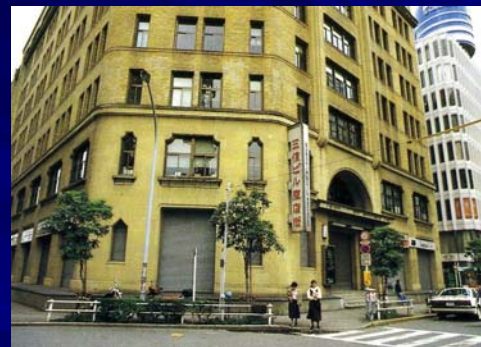
1階の床が、道路面より高くなっている
