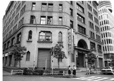
1階の床が、道路面より高くなっている (「日本の平野」平凡社より)
