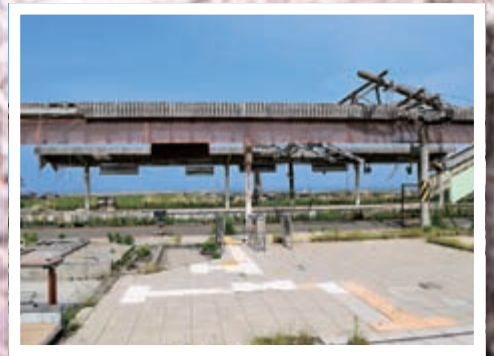
被災した富岡駅
