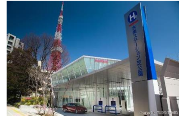
水素ステーション
