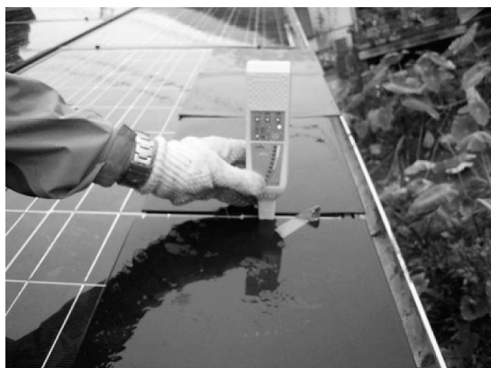
図 18 モジュール 1-02 の右クラスタの BPD 検査の様子
