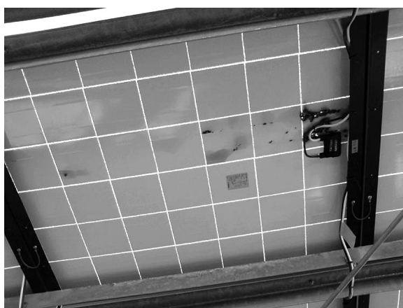
図1 産総研太陽光発電設備で発生した不具合モジュール(1)
