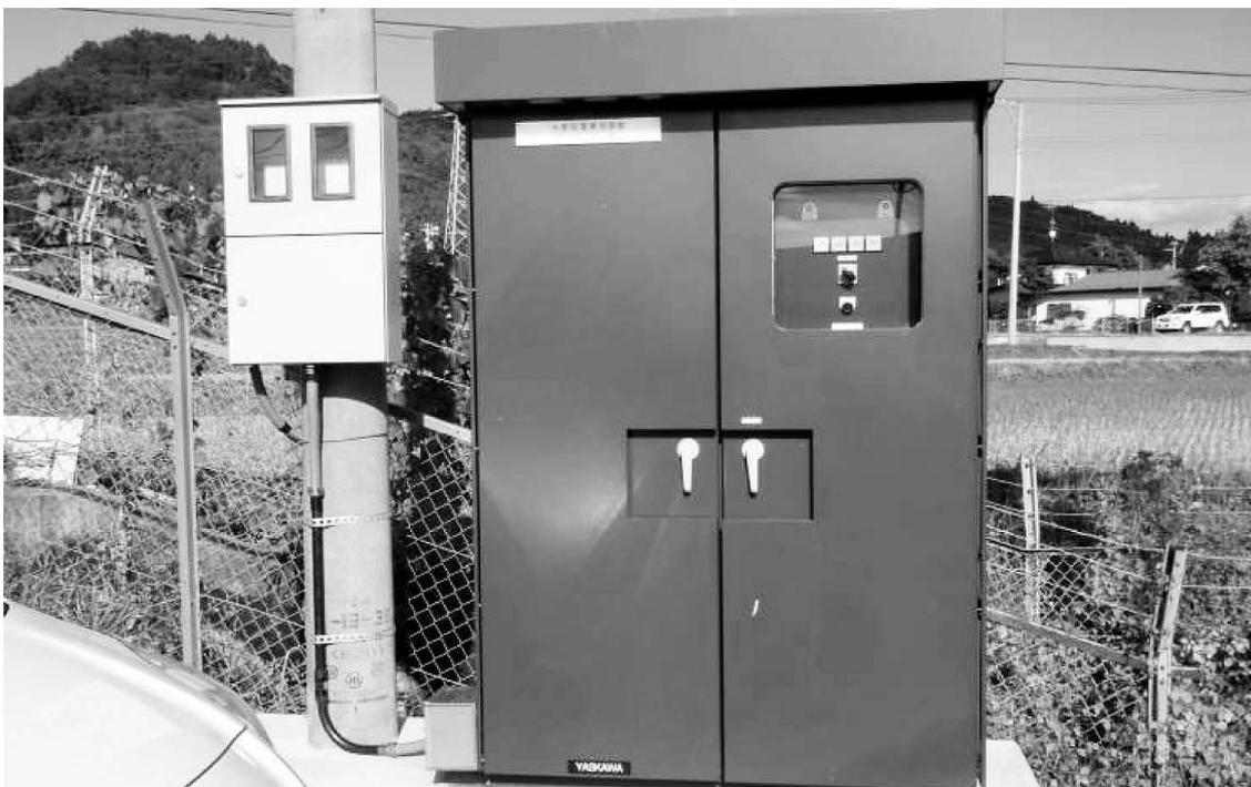
●高圧連系盤（接続回路電圧：6.6 k V，出力：100kW用）
