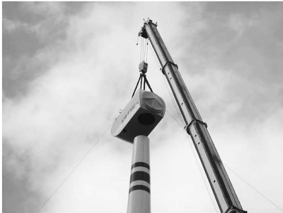
図 26 ナセルの上架
