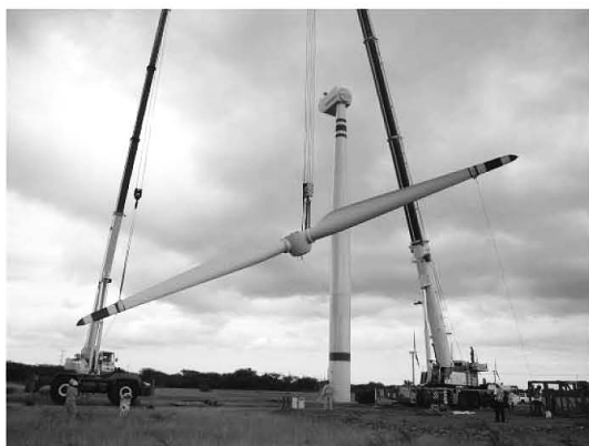
図 28 ロータの建て起こし
