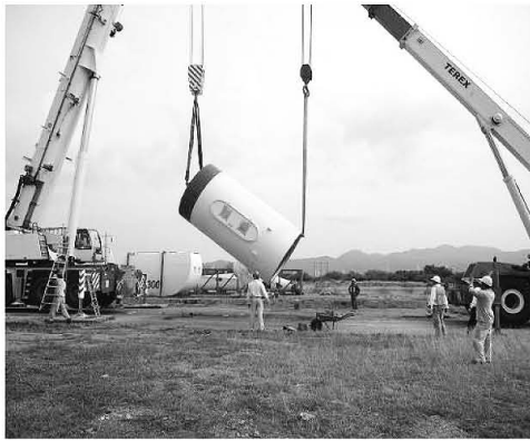
図 24 タワーブロックの建て起こし
