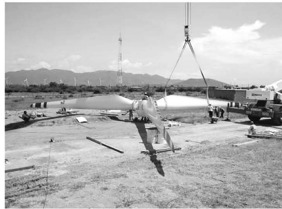
図 27 ロータの地組み
