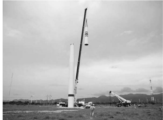
図 25 タワーブロックの上架
