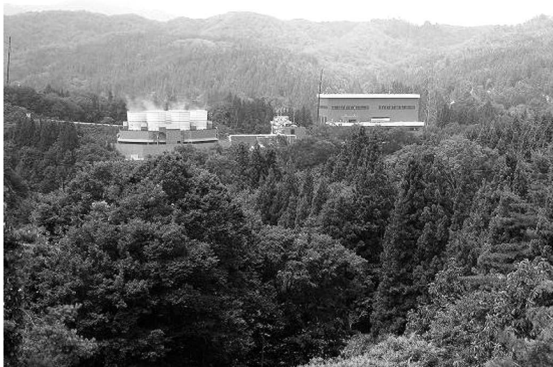
図20 奥会津地熱が蒸気を供給する柳津西山地熱発電所（福島県柳津町） 出展：奥会津地熱提供
