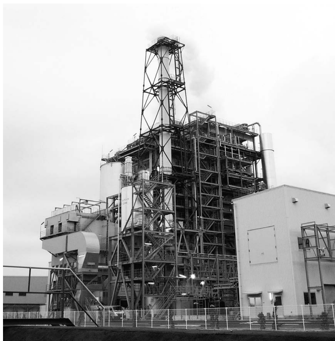
図22 川崎バイオマス発電の発電設備 出展：宇野澤撮影（2011年3月）
