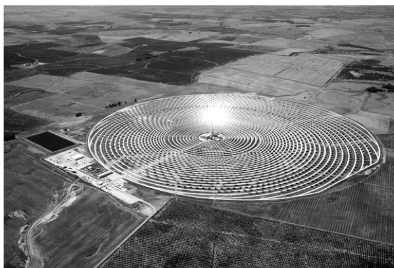
図14 スペイン・アンダルシア州で運転中のタワー型太陽熱発電所 出展：運営会社（Torresol Energy）のホームページより
