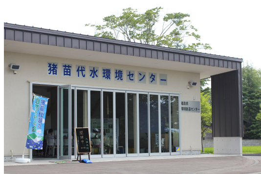
猪苗代水環境センター
