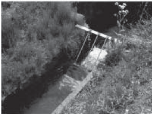
図6 排水路への除じんスクリーンの設置
