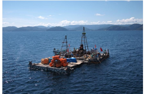
掘削地点の様子
